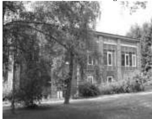
Abb1 Haus Lübeck, eines der Schulgebäude
